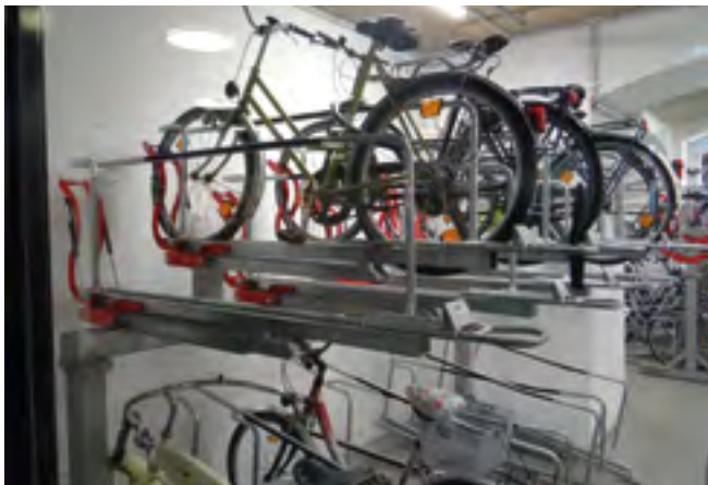
Abb. 4: Doppelstockparker, hoch/tief-Aufstellung, einseitige Einstellung
