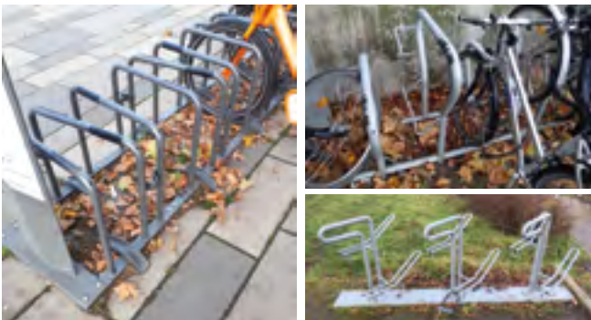
Abb. 1: Fahrradabstellanlage in tief/tief-Aufstellung (links), Fahrradabstellanlage in hoch/tief-Aufstellung (rechts oben), Fahrradabstellanlage in hoch/tief-Aufstellung über Bodenniveau (rechts unten)
